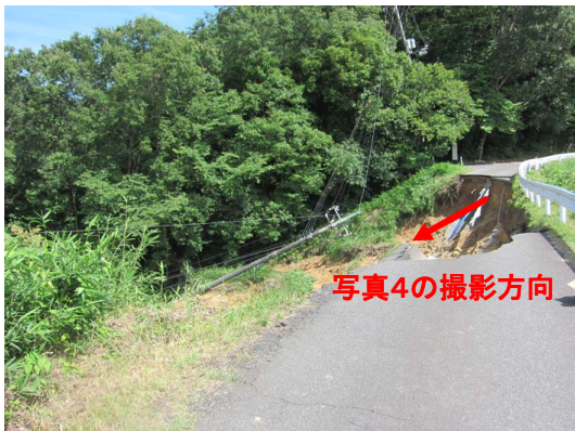
写真3 損傷を受けたため池堤体
